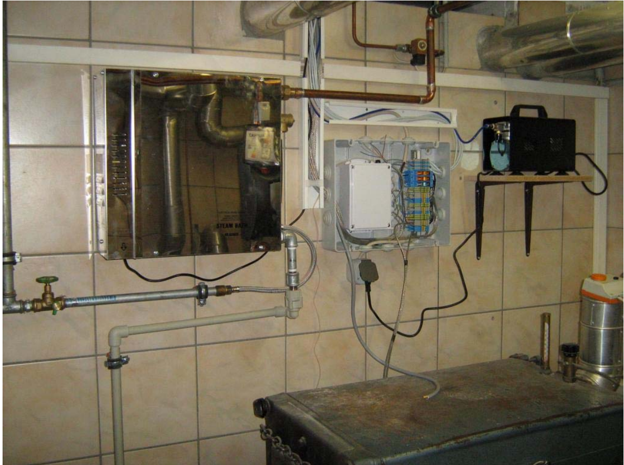
Untenstehend: Leerschläuche nach oben zur Kabine, Kupferleitung.
