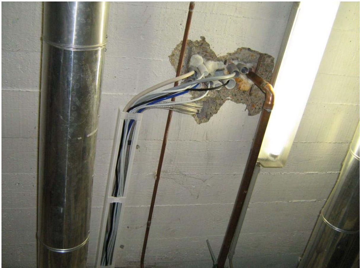
Untenstehend: Leerschläuche nach oben zur Kabine, Kupferleitung.
